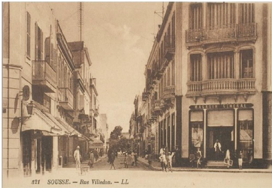
Fig 7. Carte postale de Sousse en 1906, montrant une vue en perspective de la rue Villedon prise à partir de l'avenue Krantz 40 .
