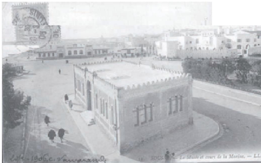
Fig. 6. Vue d'ensemble de la ville de Sousse, en 1906 39 .
