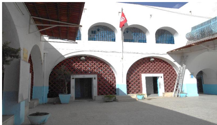
Fig. 2. Centre de formation professionnelle du bâtiment, vue sur la cour, cliché de l'auteur.
