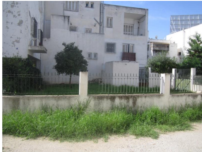
Fig. 5. Construction d'une clôture autour d'un espace collectif pour l'intégrer à l'espace privé du logement. (Crédit de l'auteur)
