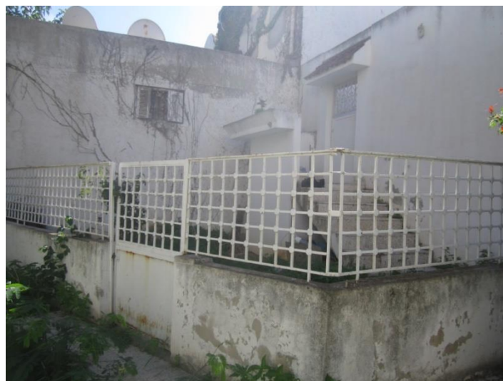
Fig. 6. Privatisation de l'espace collectif situé devant le logement afin de créer un espace de transition privé entre la rue et le logement. (Crédit de l'auteur)
