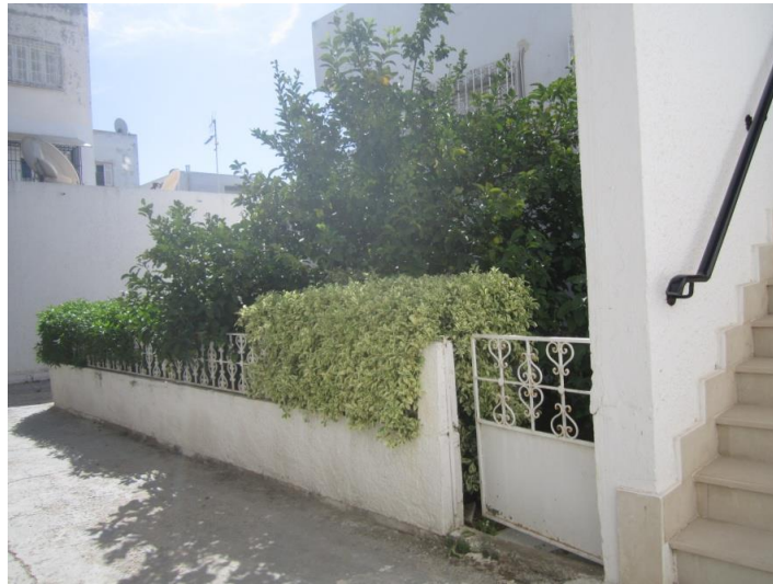
Fig. 4. Privatisation de l'espace collectif contigu aux logements : création de réserves territoriales sous forme de jardinets clôturés. (Crédit de l'auteur)
