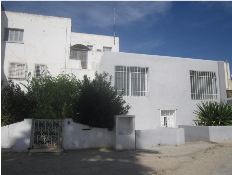
Fig. 7. Extension du bâti (partie peinte en gris) sur l'espace collectif. (Crédit de l'auteur)
