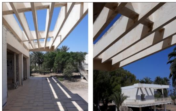
Fig. 6. Typologies de brise-soleil en béton armé courrant tout autour des bungalows. Photographies personnelles. 2018.
