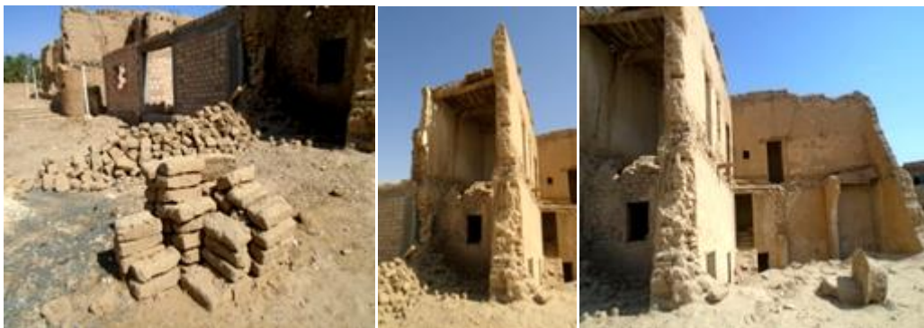
Fig. 3. La constitution d'un mur en terre (adobe) à Chetma. (Source: Auteurs, 2018)
