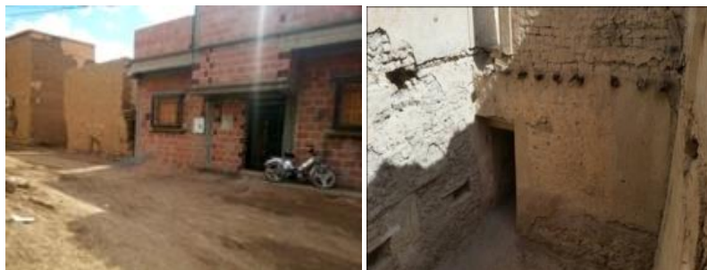
Fig. 8. À gauche, démolition/reconstruction avec des matériaux standardisés (à Sidi Okba). À droite, vol des madriers en bois pour les réemployer comme coffrage (à Lichana). (Source: auteurs, 2018).
