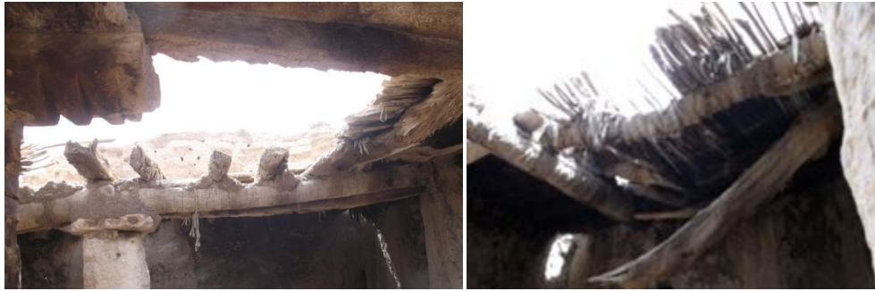
Fig. 4. Matériaux et technique de construction des planchers traditionnels à Thouda. (Source : Auteurs, 2018)
